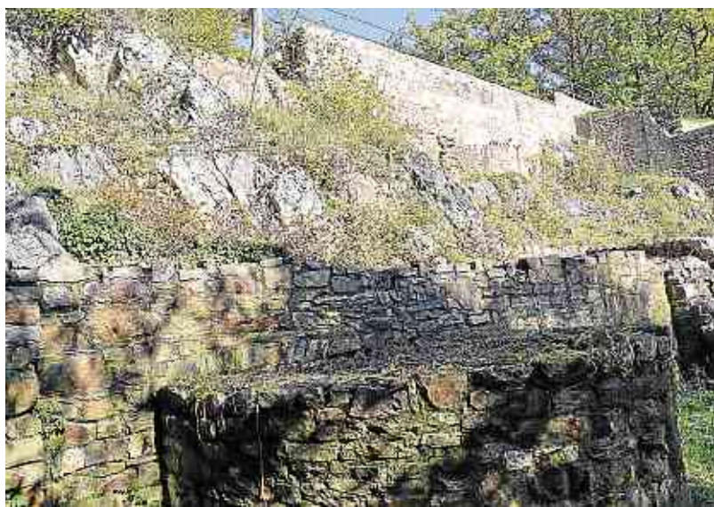
Der gewachsene Fels wurde in die Bausubstanz der „Alten Stromburg“ einbezogen.
